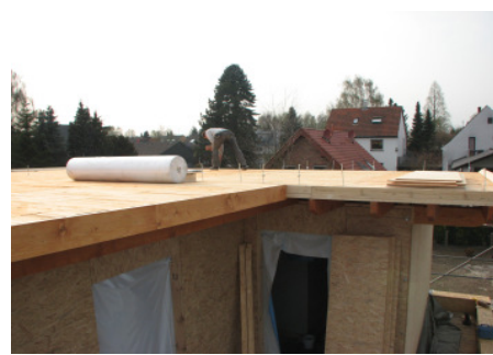
Bild 16 ...wird aufgesetzt, montiert, und
