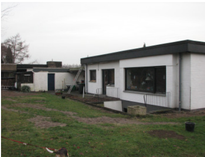
Bild 2 ...im ursprünglichen Zustand.
