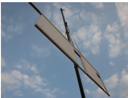
Bild 8 ...alle vorgefertigten Fassadenmodule..
