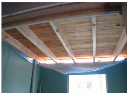
Bild 20 Der Trockenbau kann beginnen
