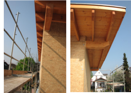
Bild 18 ...der Rohbau der Geschossaufstockung
