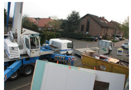
Bild 7 Mit einem speziellen Baustellenkran werden..
