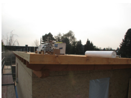
Bild 15 Das neue Geschoss-Flachdach der Aufstockung...
